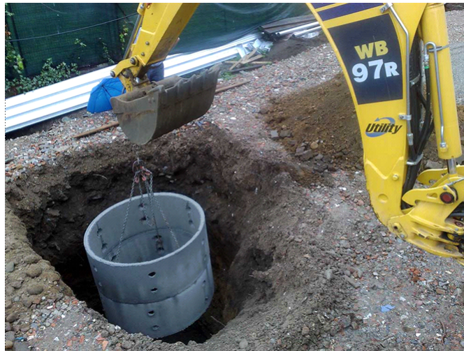
Figura: Interventi performance pozzi perdenti/drenanti
